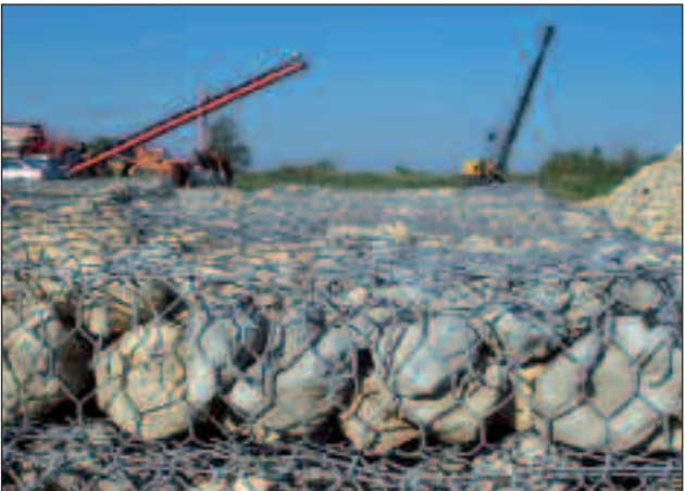
Fig. 9 - Dettaglio delle strutture antierosive flessibili.
