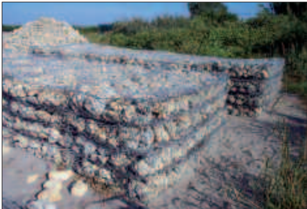
Fig. 8 - Strutture antierosive flessibili.
