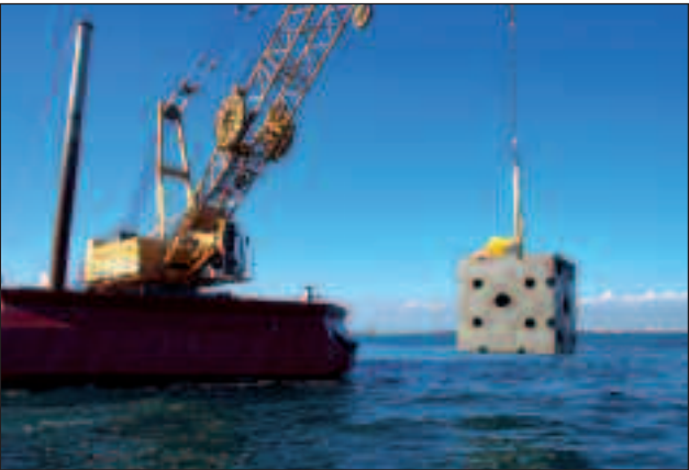
Fig. 5 - Posa in mare delle barriere di tipo A.
