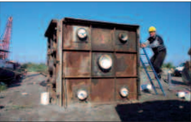
Fig. 4 - Costruzione delle barriere di tipo A.
