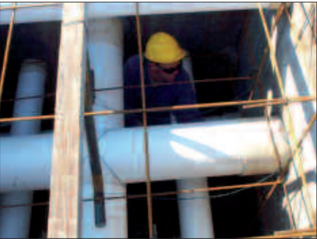
Fig. 3 - Costruzione delle barriere di tipo A.
